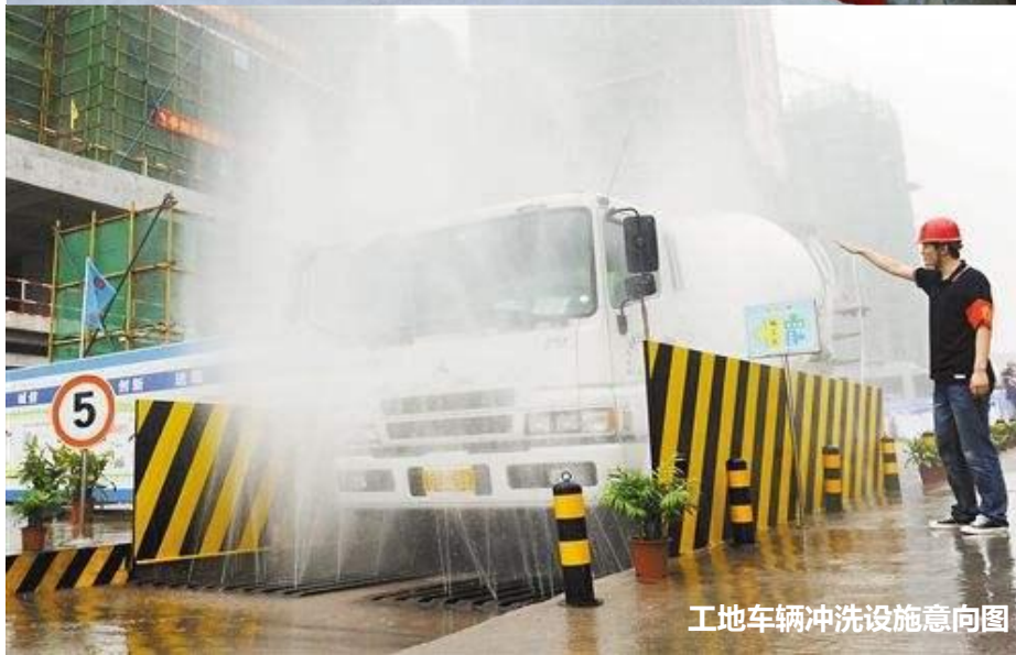
工地车辆冲洗设施意向图
