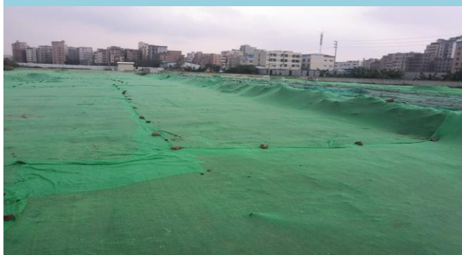
工程渣土、建筑垃圾
