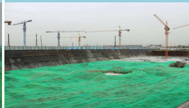
建筑土方开挖
