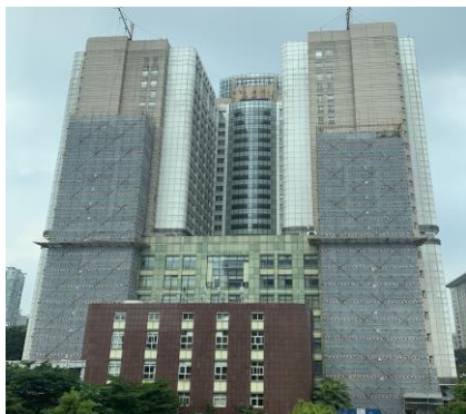
D1 钢管脚手架挂密目式安全网
